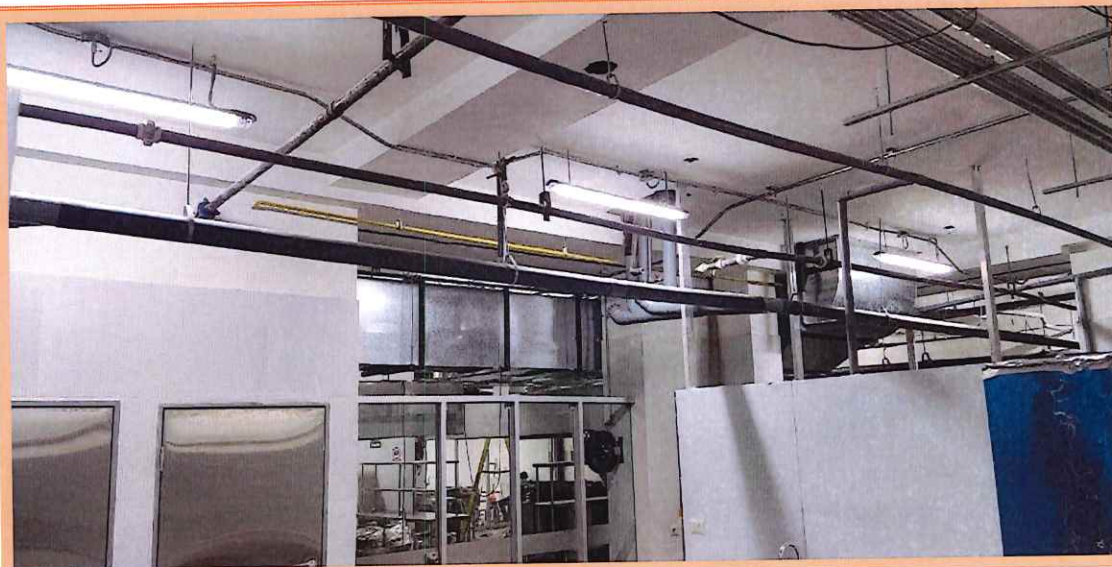
DETALLE: Cambio de tubería de fierro antiguo, por tubería de PVC LUGAR: Área de preparación de alimentos
