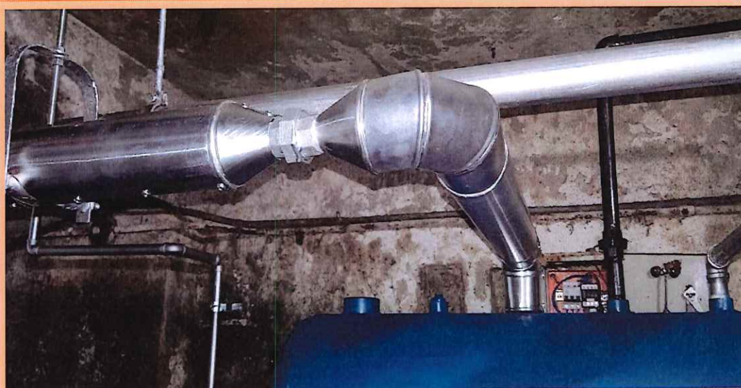
DETALLE: Tubería de retorno de condensado culminada
