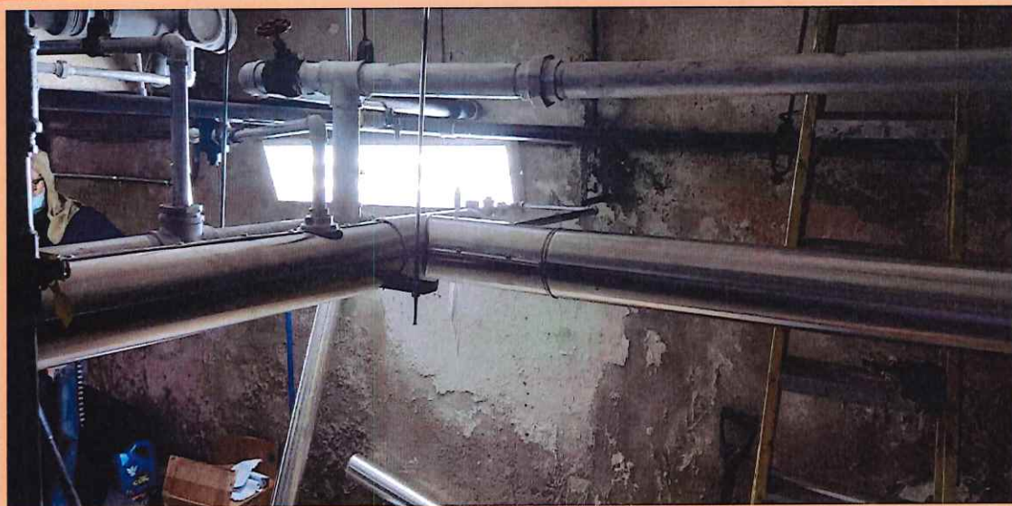
DETALLE: Tubería de retorno de condensado culminada
