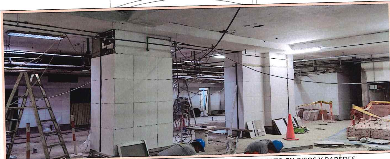
LA VISTA MUESTRA LA INSTALACION DE PORCELANATO EN PISOS Y PAREDES
