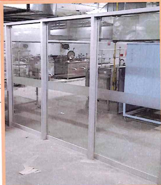
DETALLE: Colocación de bandas pavonadas y limpieza de vidrios
