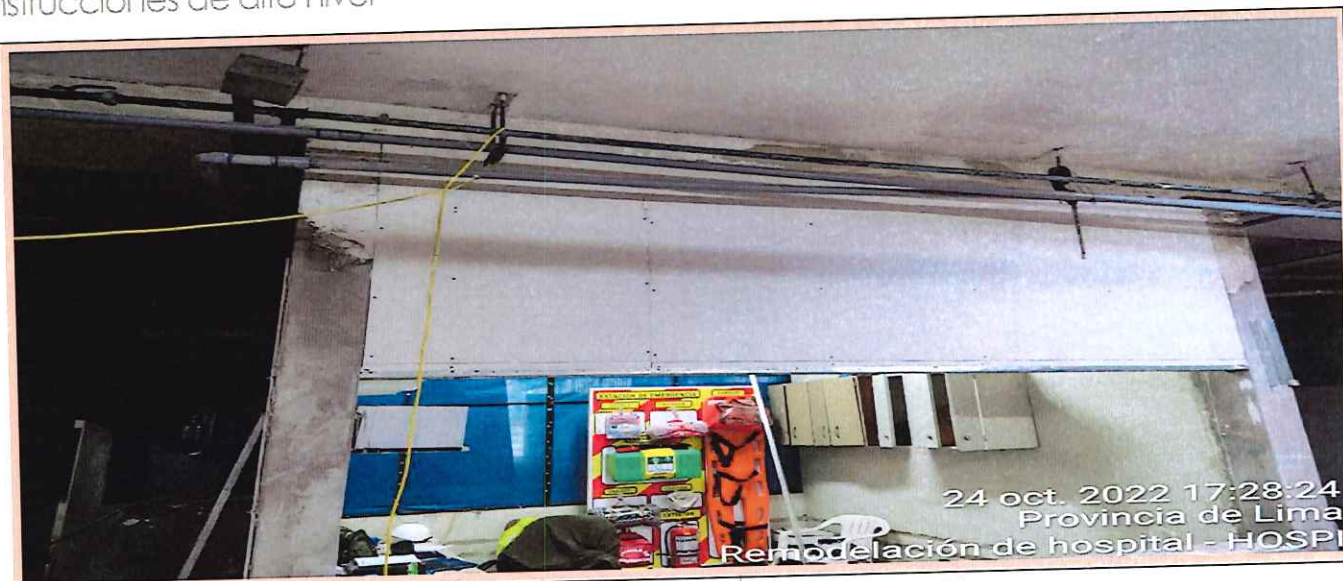
LA VISTA MUESTRA LA INSTALACION DE TABIQUERIA GYPLAC
