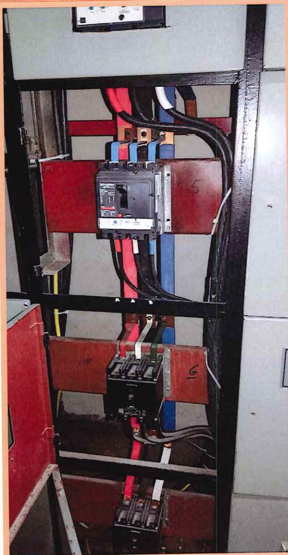
DETALLE: Barras de fuerza y llave interruptor instaladas para el tablero TD-04
