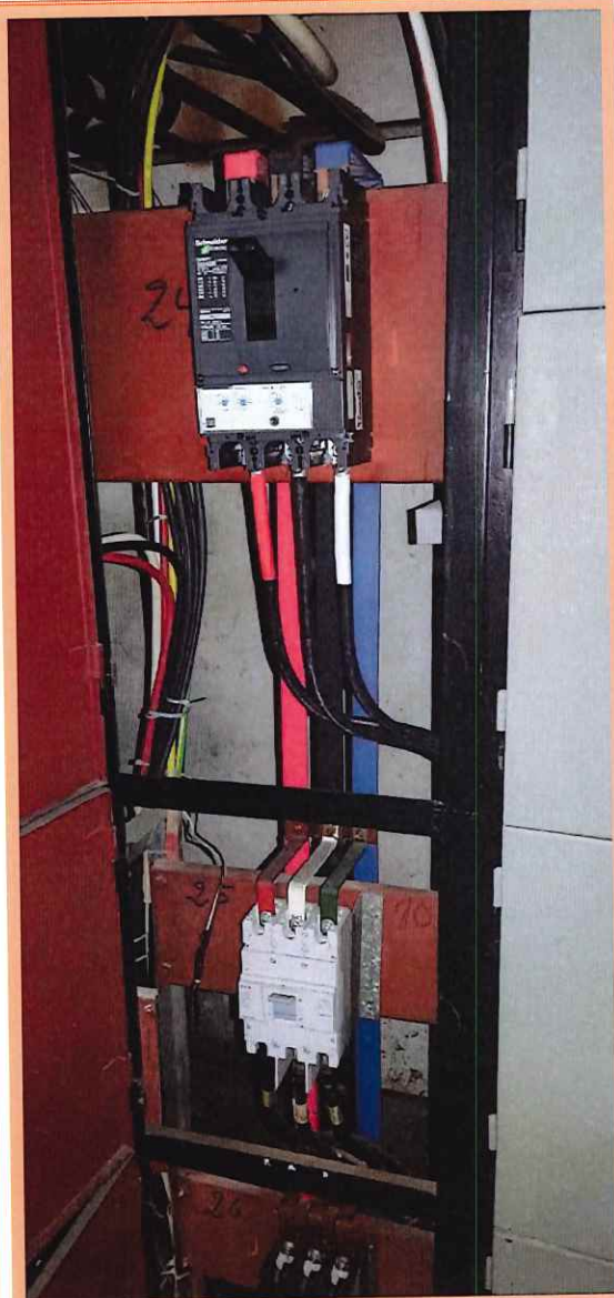
DETALLE: Barras de fuerza y llave interruptor instaladas para el tablero TD-02
