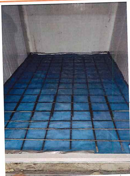
DETALLE: Colocación de malla de acero corrugado en cámaras frigoríficas
