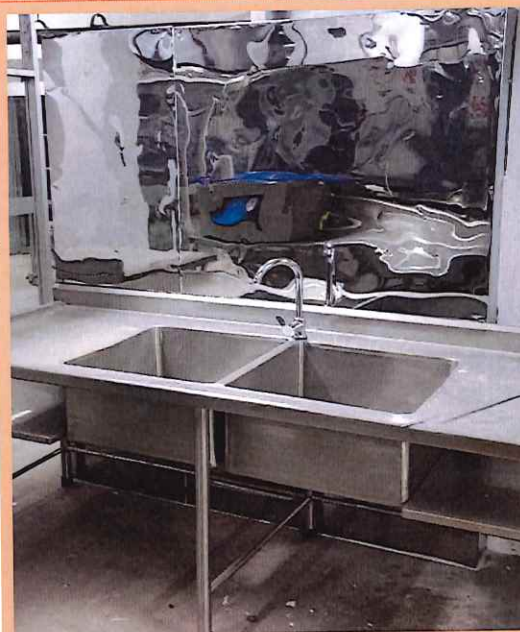
DETALLE: instalación de lavadero
