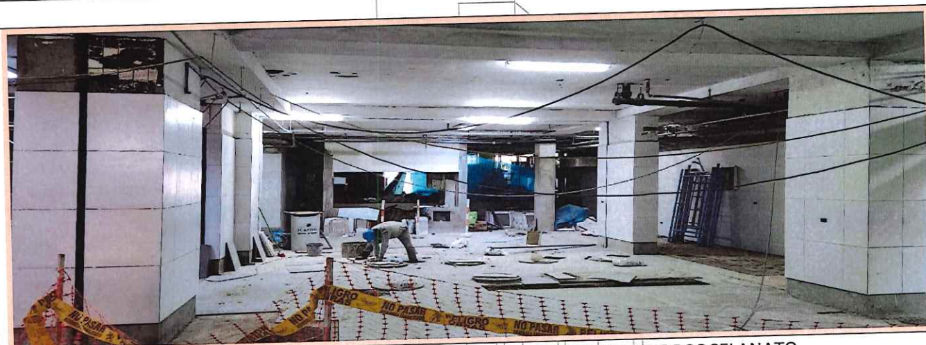
LA VISTA MUESTRA LA INSTALACION DE PISOS DE PORCELANATO
