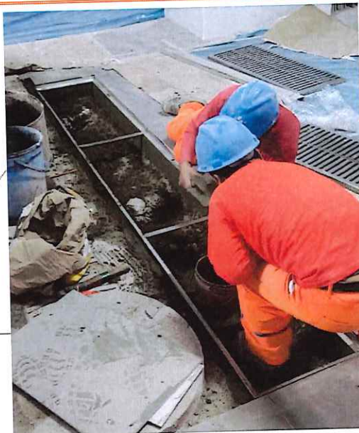
DETALLE: Forjado de rejillas
