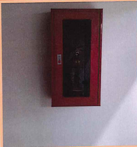
DETALLE: Instalación de extintor con su gabinete
